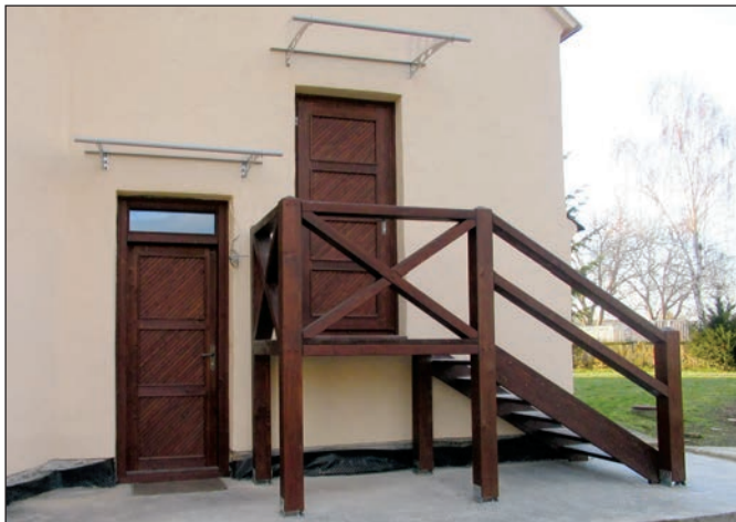
Pohľad na novoosadené drevené schody na panský chór. Snímka: MH
